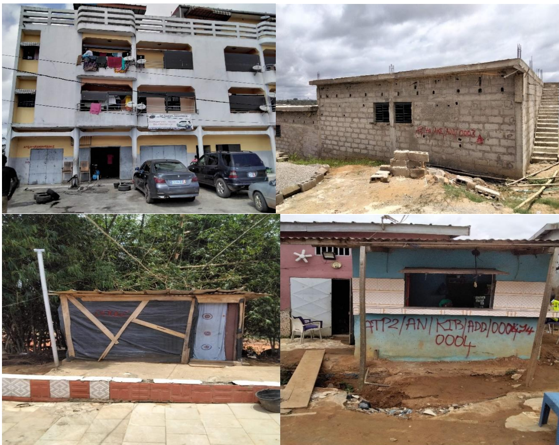
Photos 10, 11, 12 & 13 : quelques types de constructions dans l'emprise du projet
